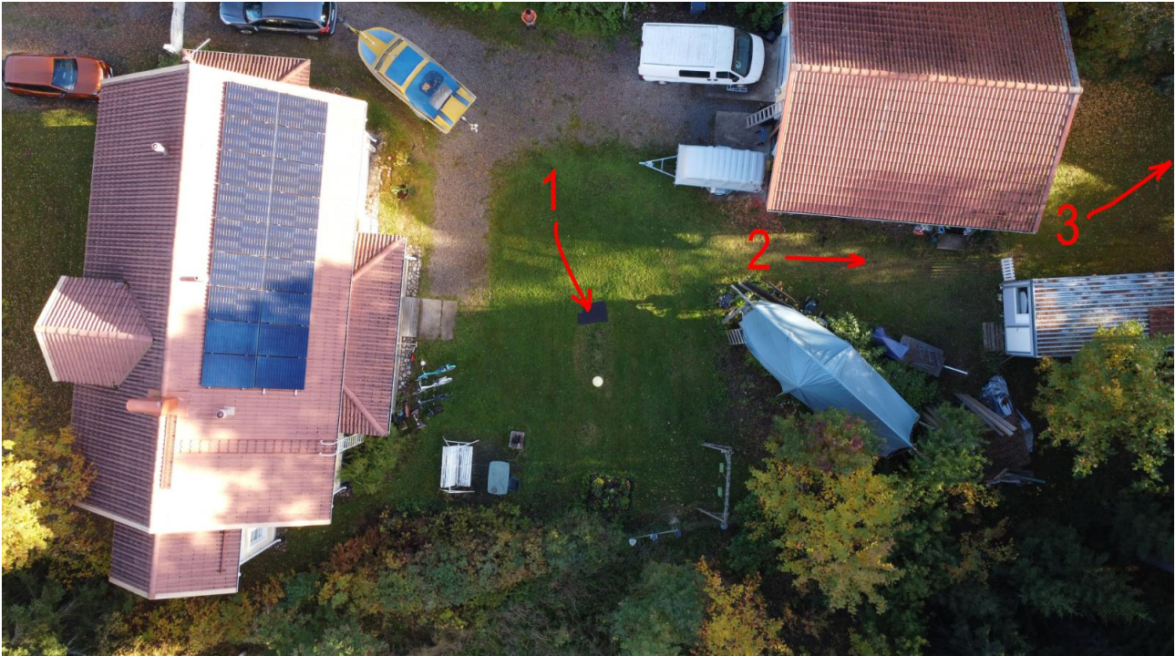
Kuva 6. Mittauspaikat 1, 2 ja 3 dronella kuvattuna.
